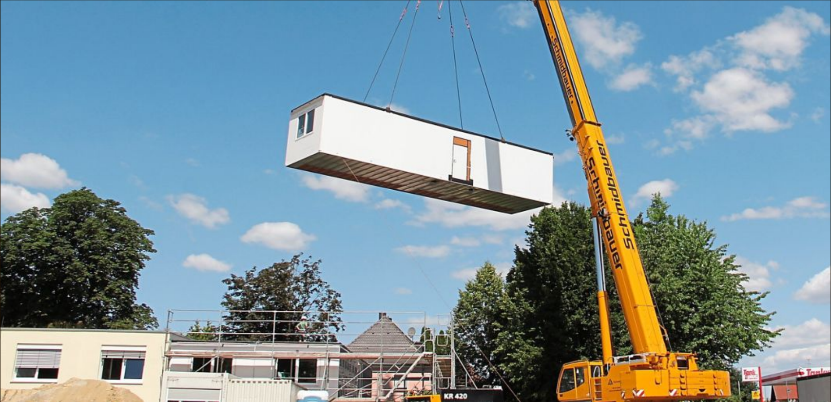
Die Module schweben förmlich ein.
